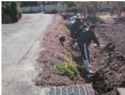
(用水路の泥上げ)
